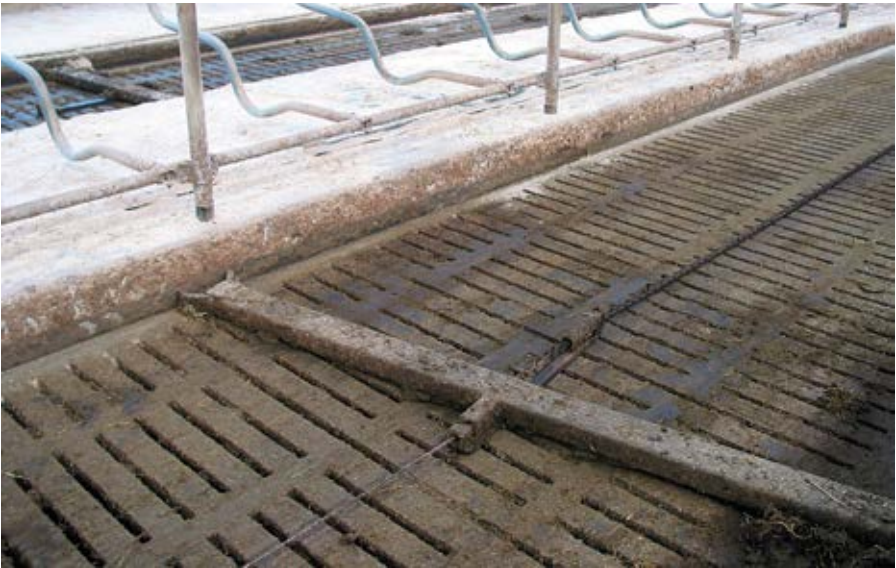
Pintaraappa rakolattialla eli betoniritilällä.
