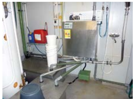
Kierrätyspesuri varastovesisäiliöineen.
