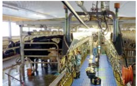
Rinnakkaisasema, jonka rintaputket nousevat. Pikapoistuminen.
