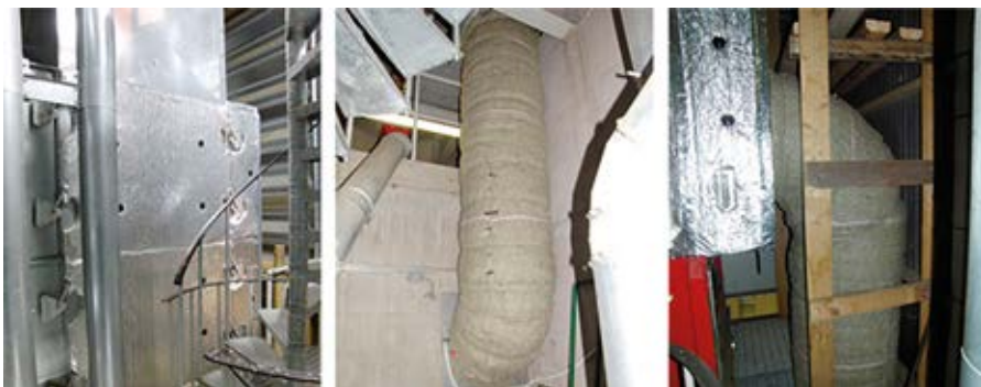
Kuva 10. Kuivurin ilmaputki, etuseinä ja sivuseinät kannattaa eristää.
